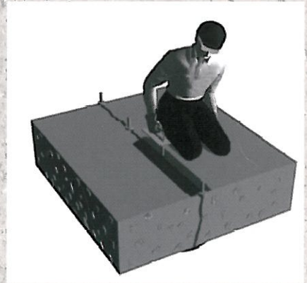
Fig. 1—Installation of cap seal.
