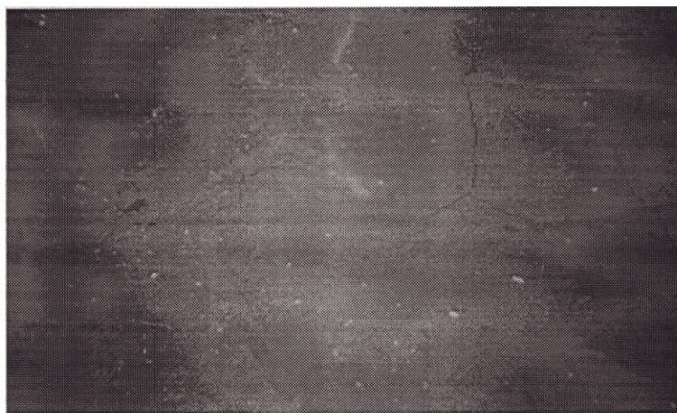
الشكل (١٤) إنخفاض كثافة تشقق سطح البيتون الطري للبلاطات المصقولة
